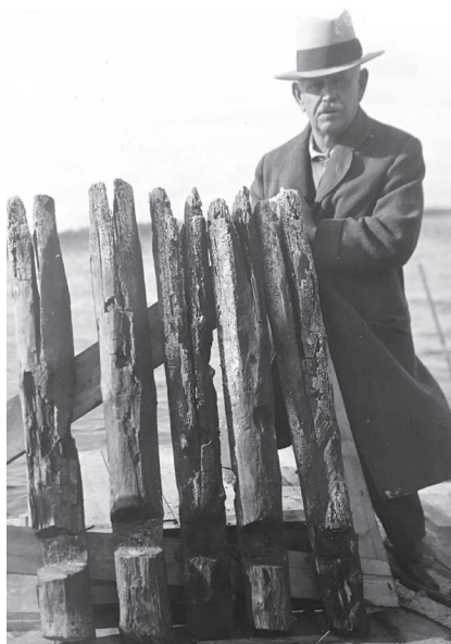
Figur 6. Arvid Zetterling ståendes på sin undersökningsflotte 1932. Framför honom står en rad byggnadsdelar från en del av en gavel till en knuttimrad byggnad. Foto: ATA.
