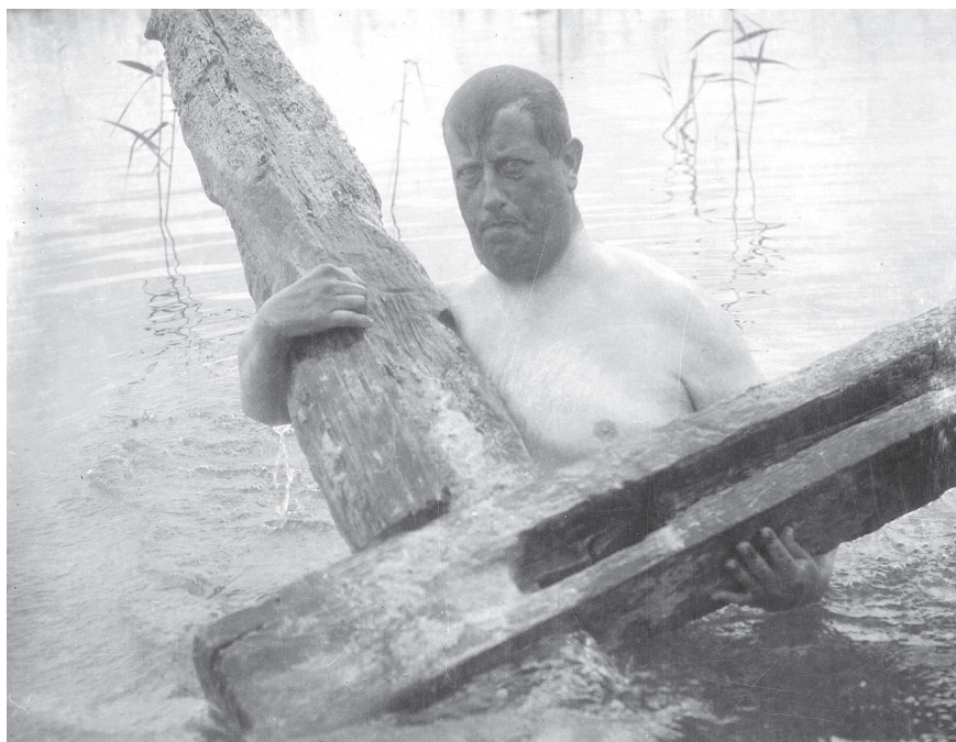
Figur 4. Arvid Zetterlings kollega Lennart von Post, bärgandes en syll och en hörnstock från ett skiftesverk. Foto: Ture J. Arne 1927. ATA.
