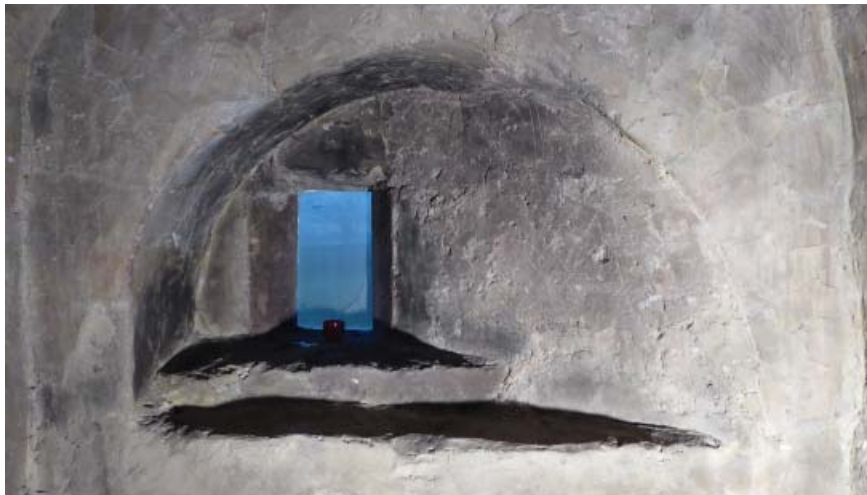
Figur 4. Den välvda nischen i den igensatta portalen i S:t Olofs kyrka. Foto Magnus Källström.
