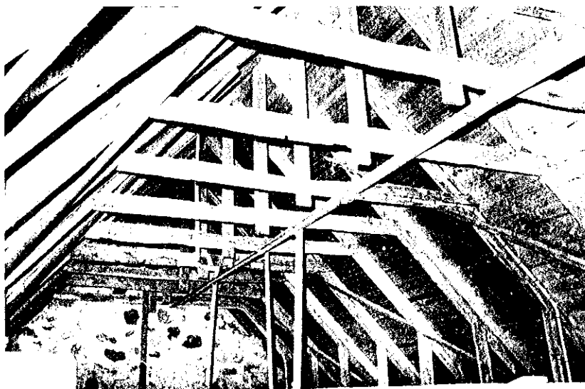
Fig. 1. Ombyggda takstolar över långhuset i Skårby kyrka, Skåne. Hanbanden är återanvända sparrar daterade till tiden efter 1414-1470. Foto Mats Anglert 1986.
